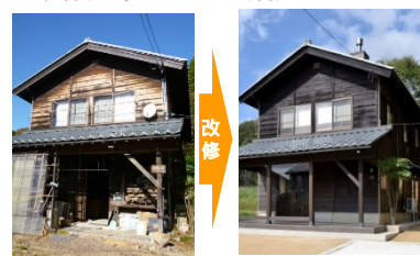
改修前 (空き家)
